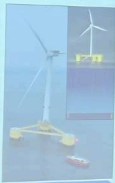
半潛式 (Semi-submersible) WindFloat Atlantic 風機(2020)
