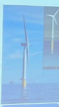
單浮筒式 (Spar-buoy) Hywind Tampen 風機(2023)
